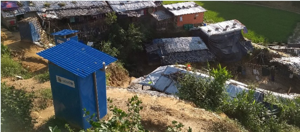
Figure 5 : Latrines d'urgence à Cox's Bazar, au Bangladesh, présentant un large surplomb. Solidarités International
