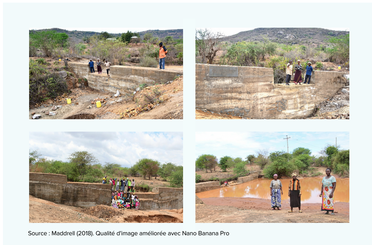
Figure 39 : Photos de deux barrages de sable illustrant les différentes tailles : un barrage de sable de 200 sacs de ciment (en haut) et un barrage de sable de 850 sacs de ciment (en bas)
